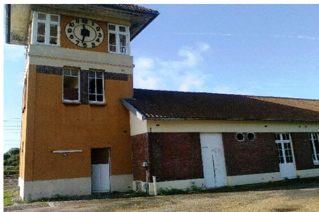
L'horloge et le CIS FRET (en état de délabrement)
